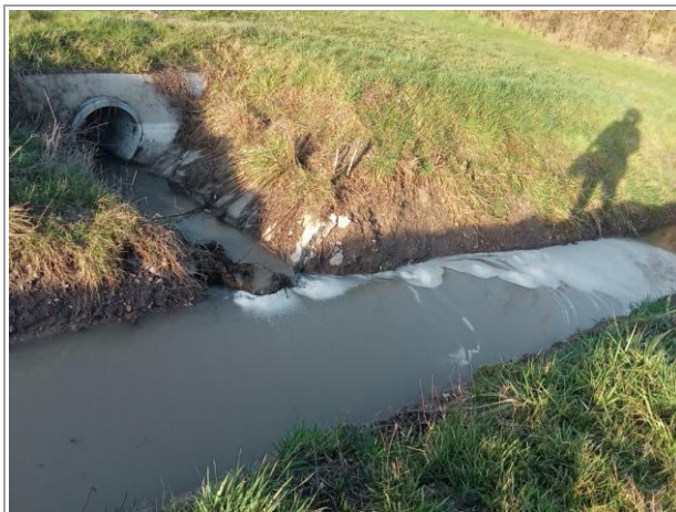
Fossé SNCF débouchant sur le fossé communal, photo C.D.
