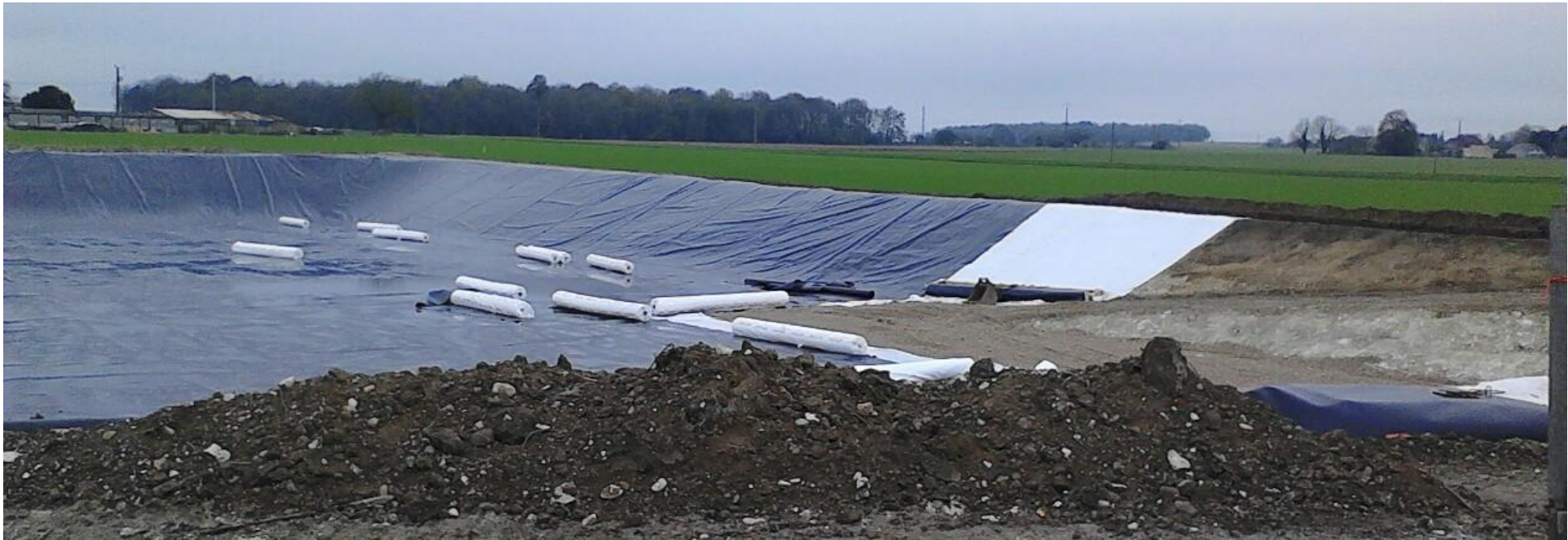
23 nov. préconisations de DDT, onema à respecter : tuyaux de drainage ..et évacuations de l'eau qui pourrait remonter, soulever les bâches
