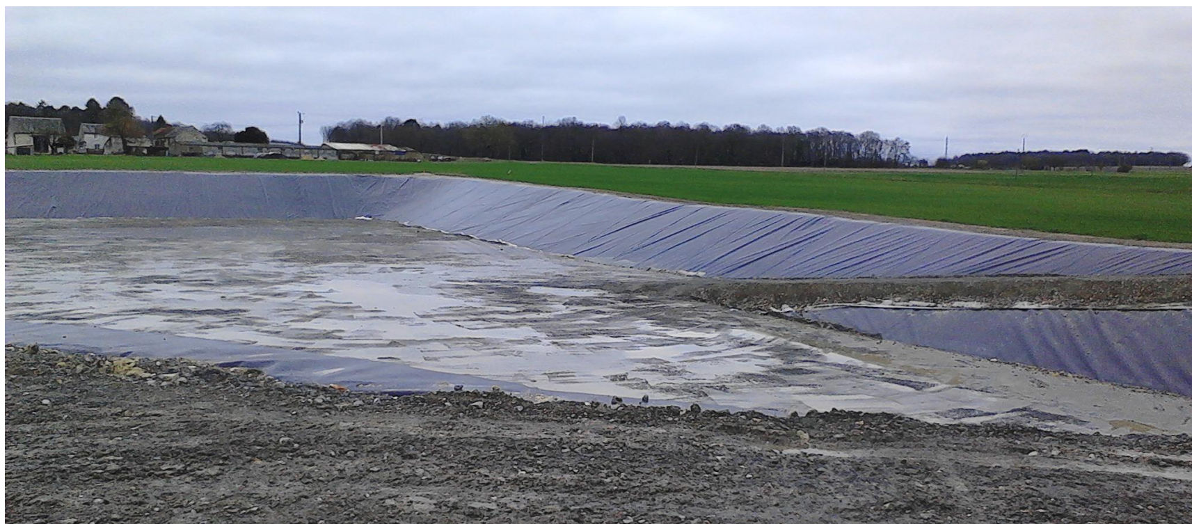
Surface nivelée, bassin probablement terminé. photo 5/2/2016
