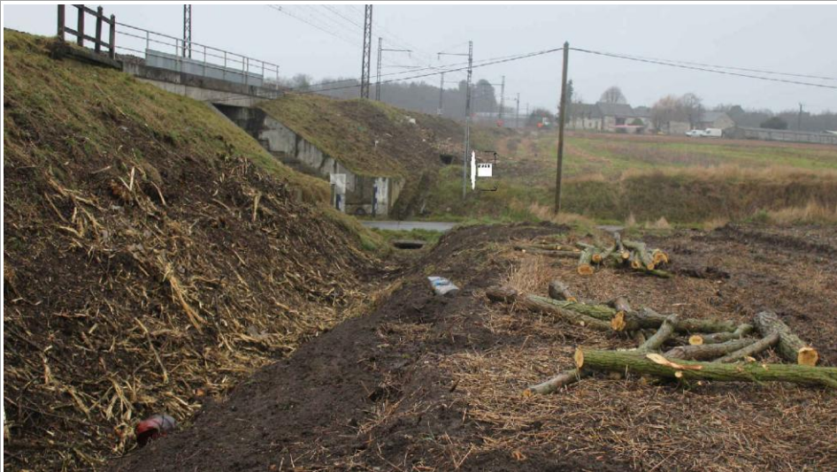
passage de la buse sous voie coté bassin rétention, sans siphon notable En passant sous la route : la hauteur siphon semble être de 3,5 m
